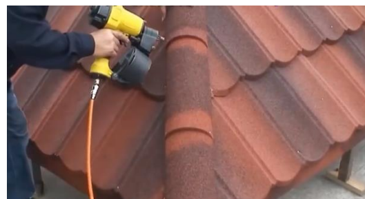
图 21 斜脊瓦安装——固定部位
