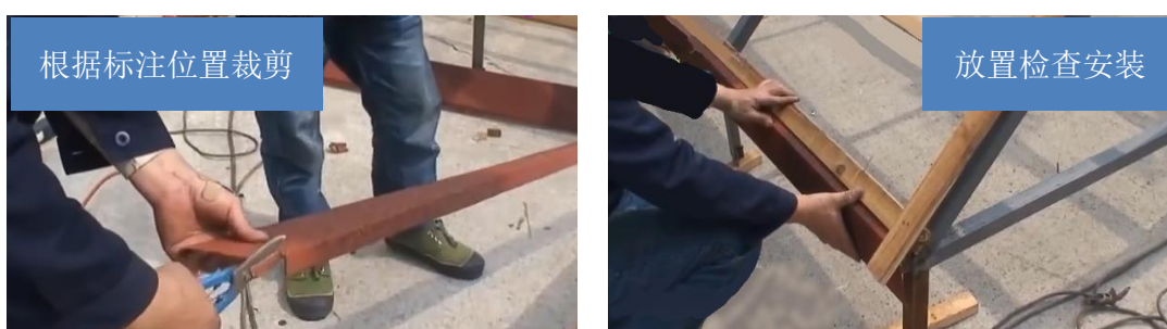
图 10 檐板与山墙挂瓦条搭接细节
