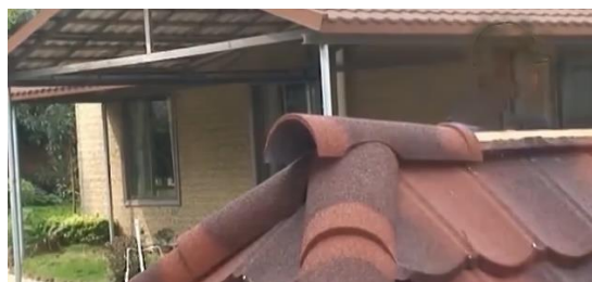
图 22 裁剪脊瓦制作三通
