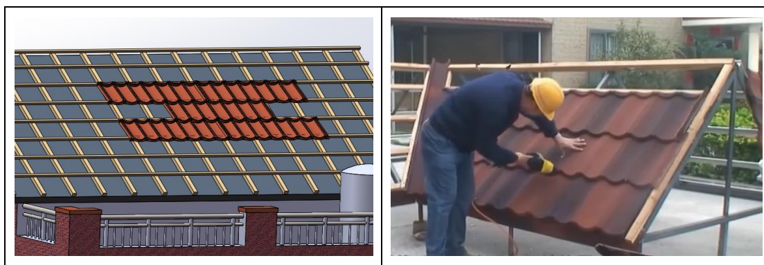
图 13 主瓦铺贴原则—“工”字型
