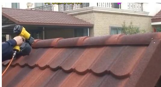
图 20 顶脊瓦安装——固定部位
