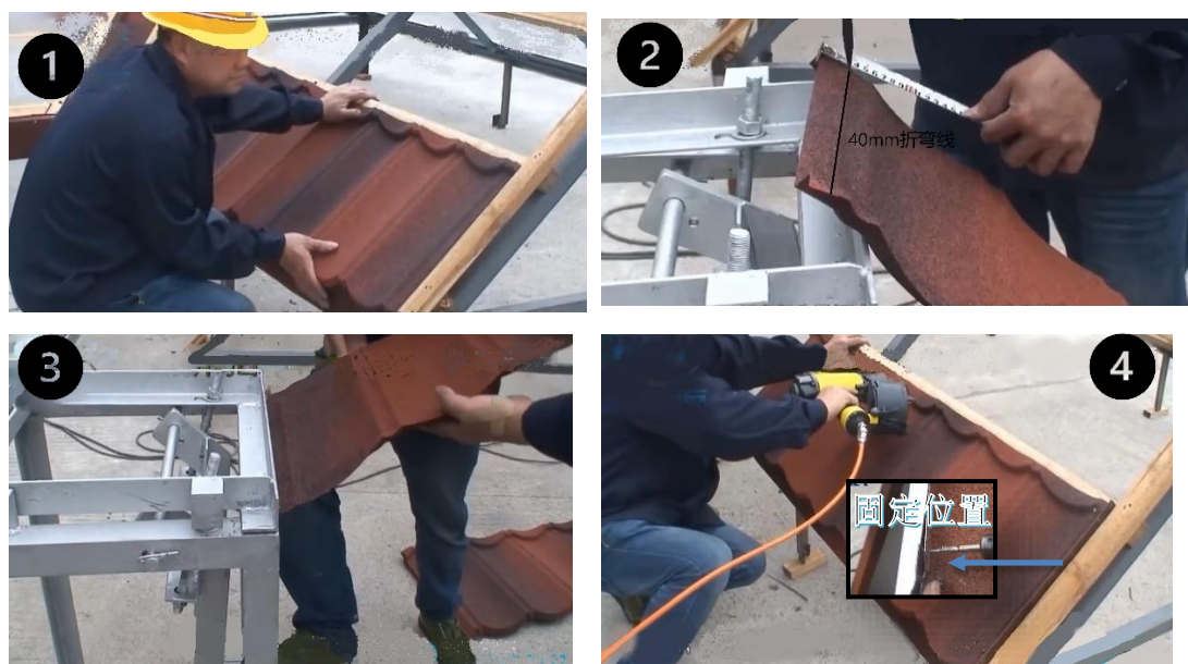
图 14 主瓦与山墙挂瓦条搭接细节
