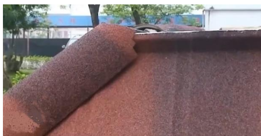
图 22 裁剪脊瓦制作三通
