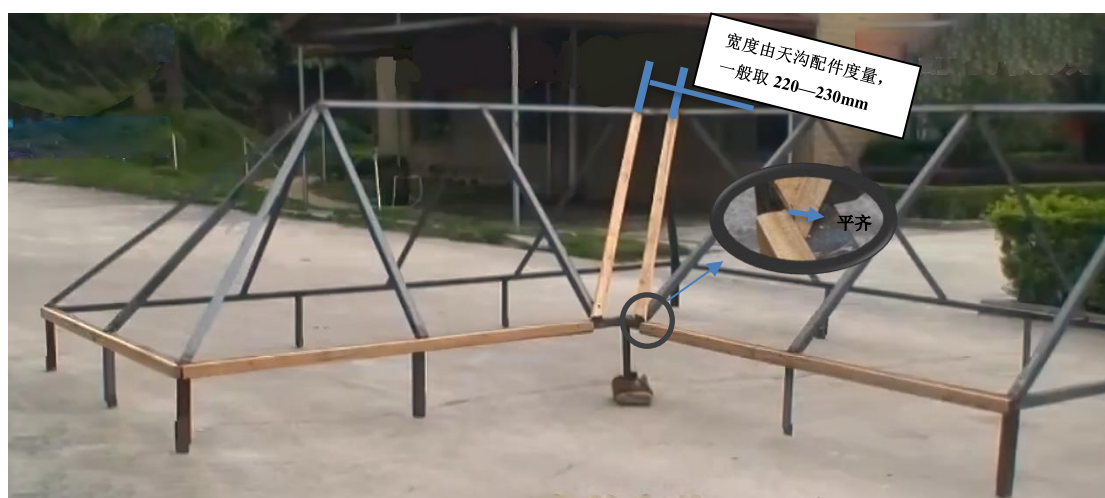
图 2 天沟挂瓦条及檐板挂瓦条
