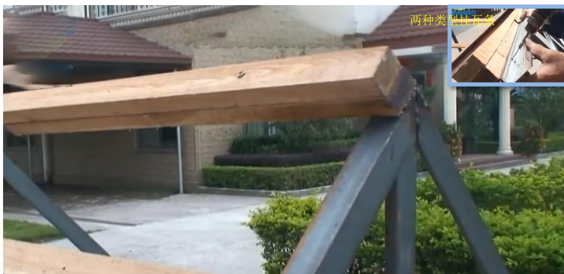
图4 顶脊挂瓦条
