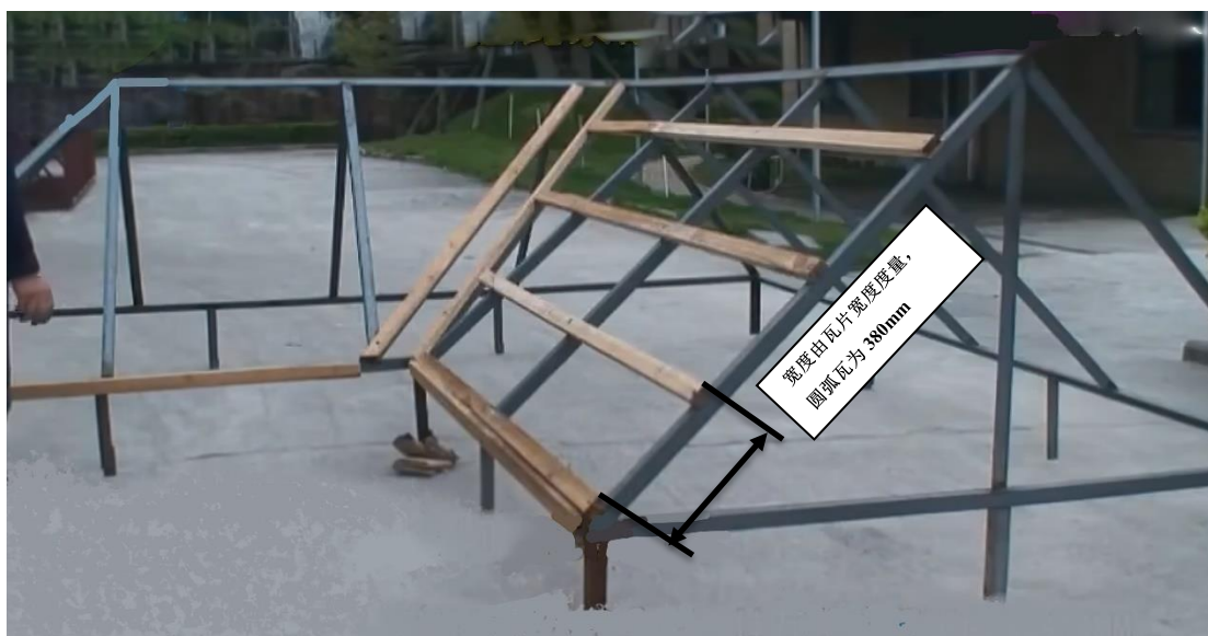
图3 第一条挂瓦条与中间挂瓦条
