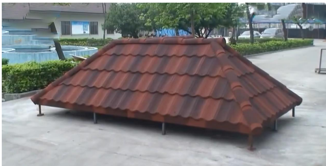
图 25 钢结构龙骨挂瓦铺贴条效果图
