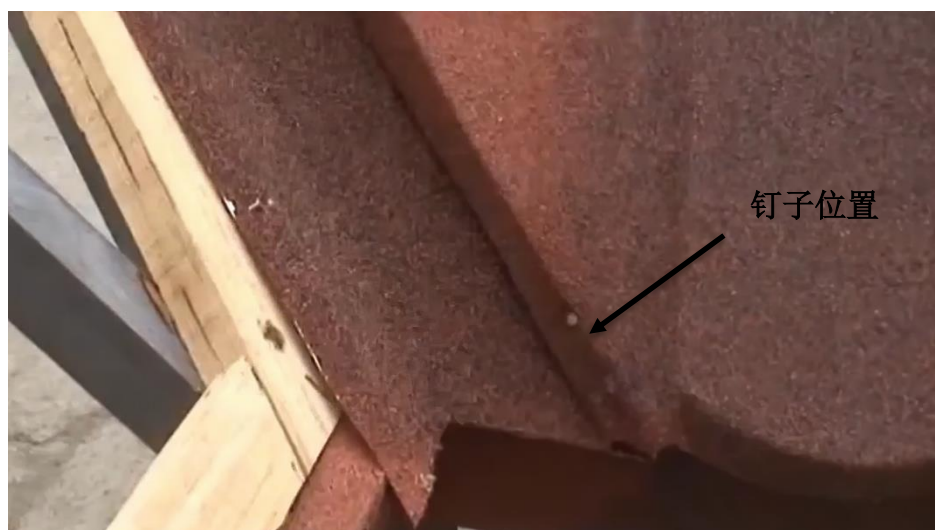
图 15 主瓦与天沟挂瓦条搭接细节
