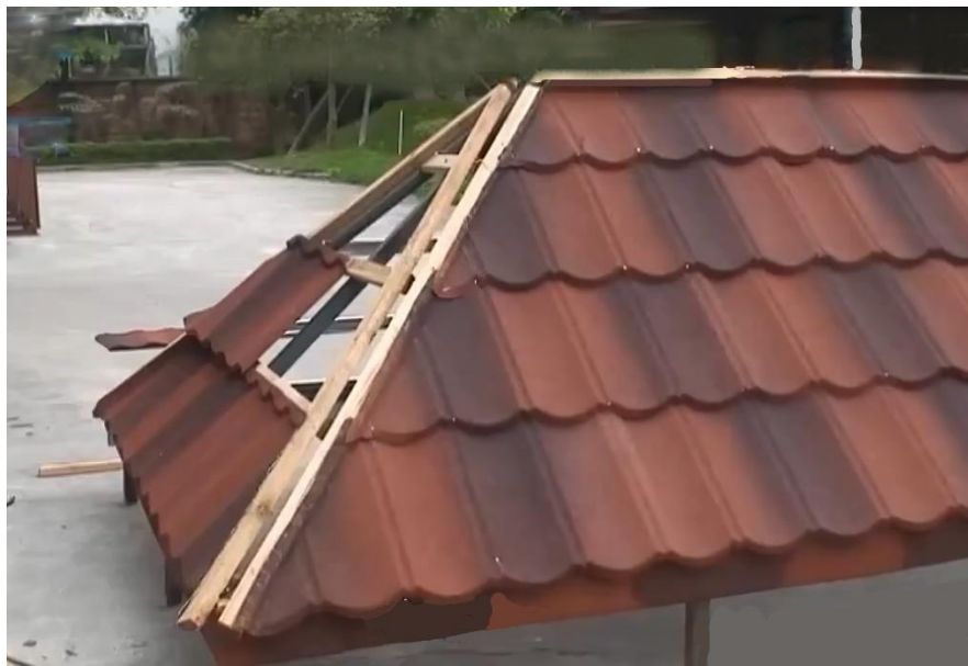
图 16 主瓦与斜脊挂瓦条搭接效果
